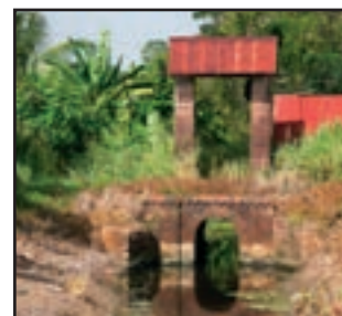
Cover: Sluis te Leonsberg - Noord Paramaribo
