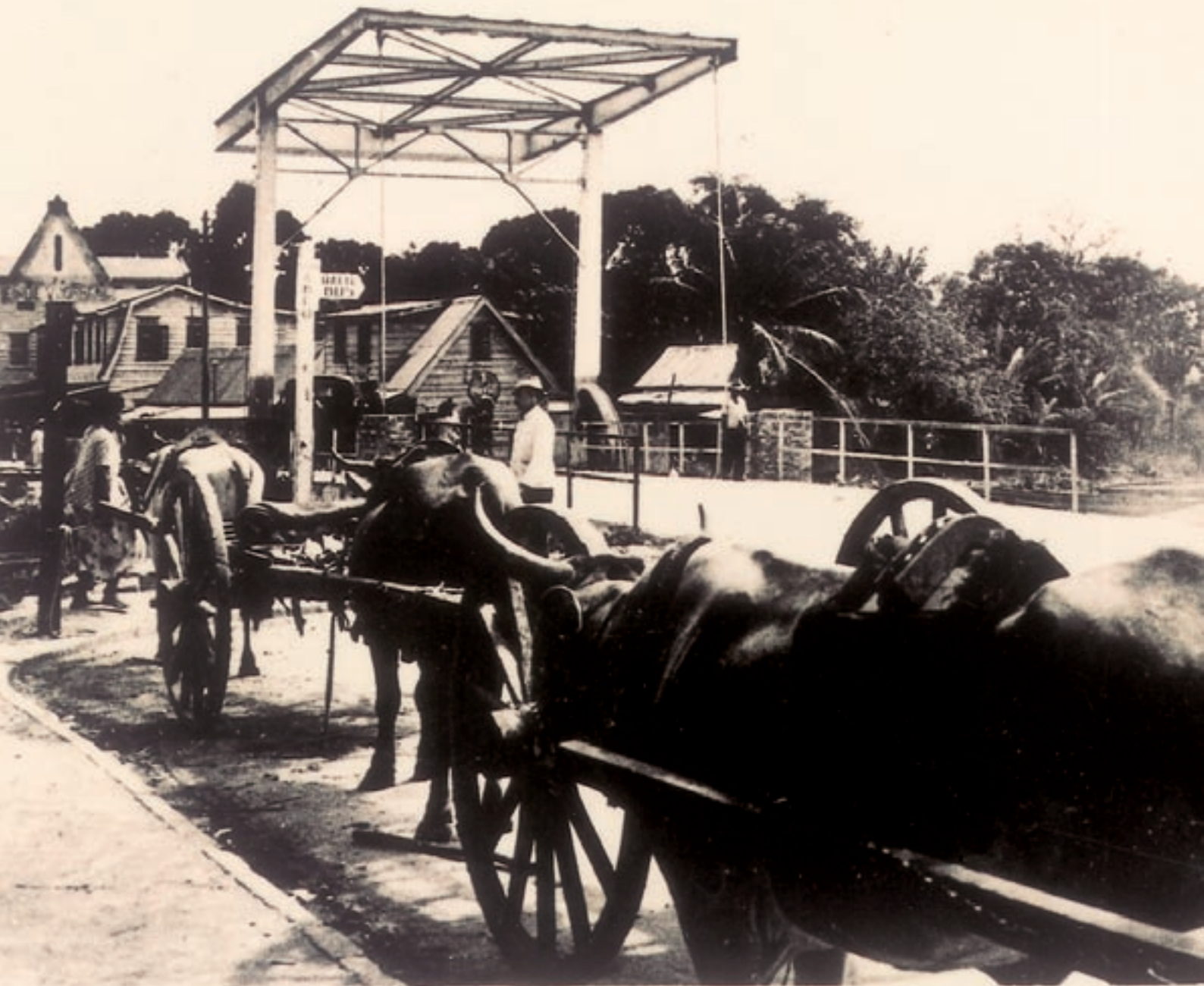
OPHAALBRUG OVER SARAMACCAKANAAL
